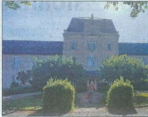
À l'Ehpad de l'hôpital local de Reignier, un des services est confiné à cause de cas de Covid-19. Photo Le DL/A.S.
