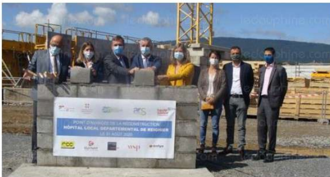
Les acteurs de ce chantier colossal ont posé la pierre de la reconstruction de l'hôpital local-départemental (Ehpad), le plus important du département en termes de lits. Photo D R
